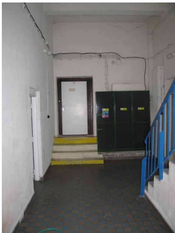
Chodba v 1.NP
