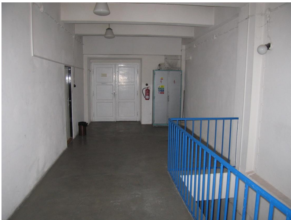
Chodba se schodištěm ve 2.NP
