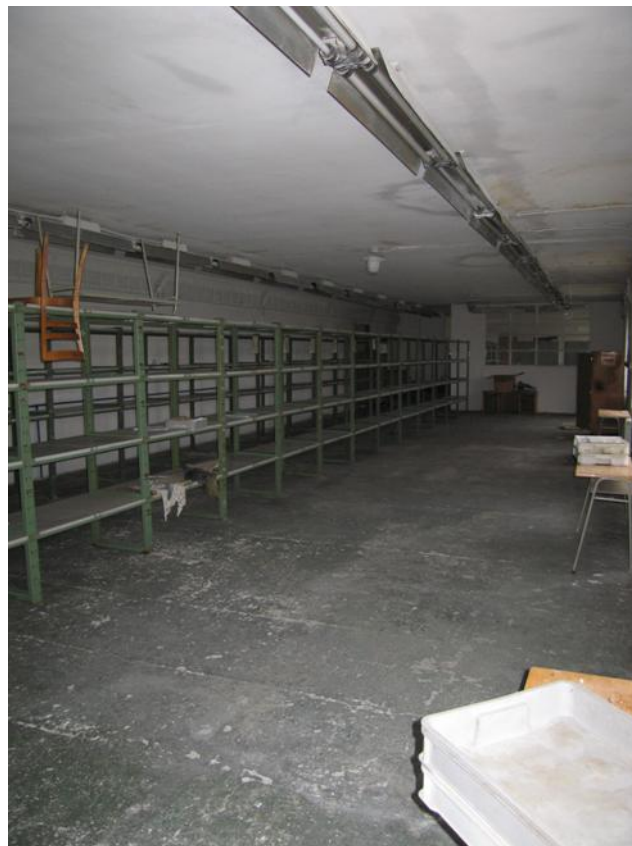
Plocha místnosti ve 2.NP ze které budou prováděny kanceláře
