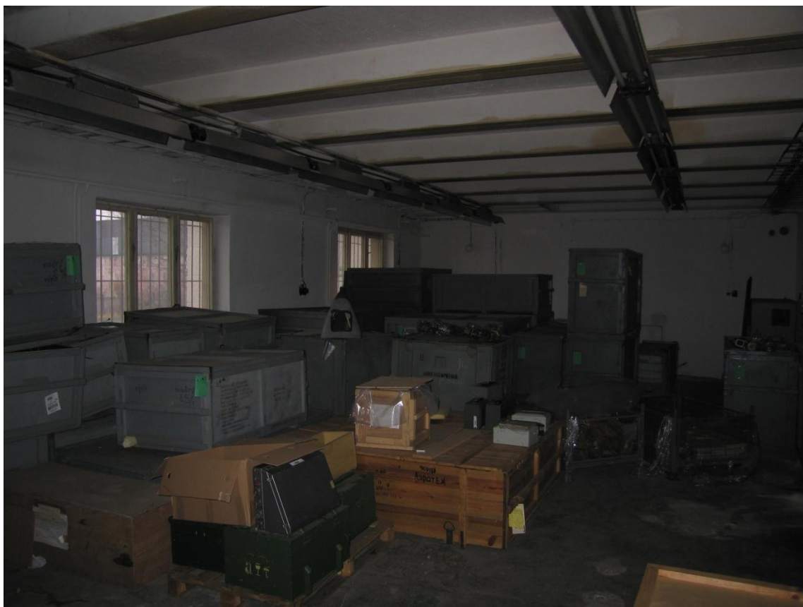
Plocha skladu v 1.NP (před zahájením prací bude vyklizeno)
